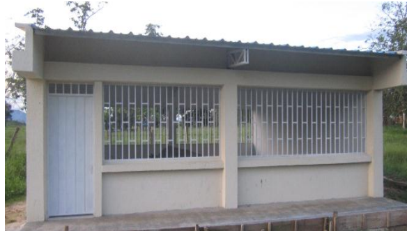
Techo Polideportivo San José del Fragua - I.E
