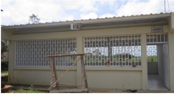
Construcción aula La Montañita – I.E. Brisas de San Isidro
