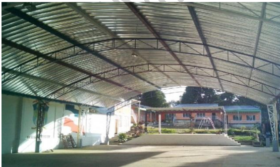
Construcción aula San Vicente – I.E. Arenoso Parroquial
